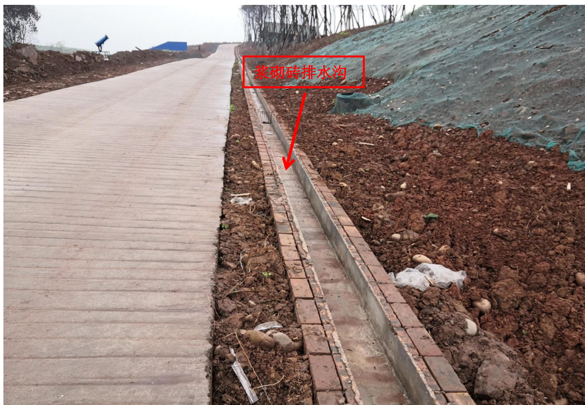
项目区已建成道路
